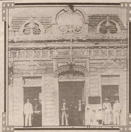
Antigo prédio nos anos 40.
